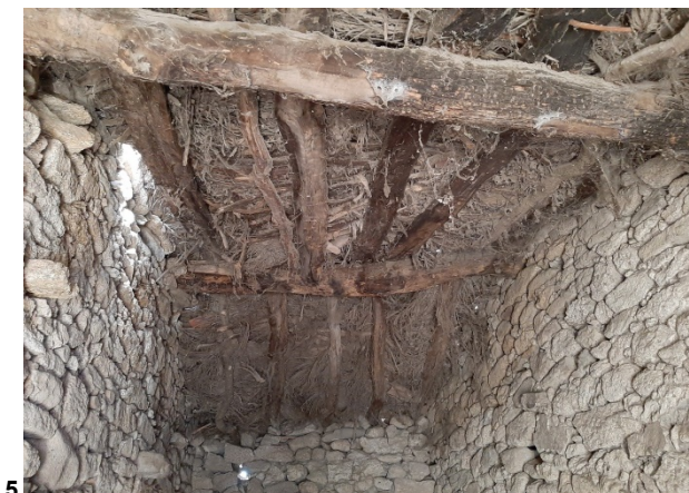
Tipos de piedras y técnica de piedra seca. 1-4.- Caseta de El Alisón en Campogrande, en la zona nororiental de Aliste, levantada en mampostería enripiada de esquisto, colocado con la técnica de piedra seca, y tejado de losas de pizarra; 5.- Pajar de Los Canegos, en Pino del Oro, en la zona suroriental de la comarca, construido en cantería y mampostería enripiada de granito en seco; 6.- Interior de este pajar donde se advierte la techumbre, a teja vana, de viquería, cantiaños y escobas
