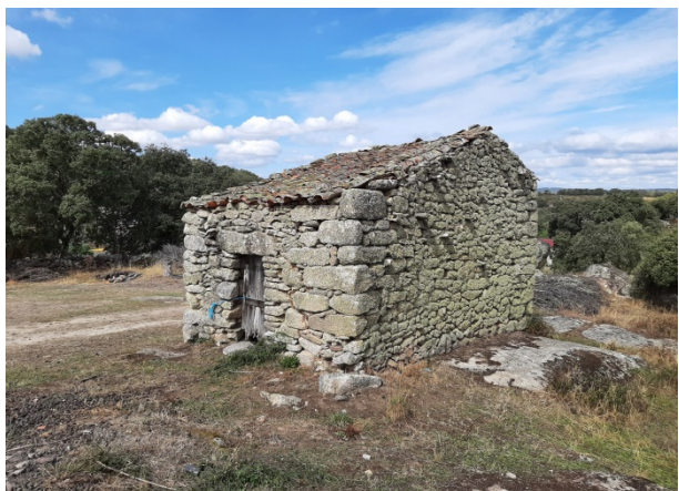
Tipos de piedras y técnica de piedra seca. 1-4.- Caseta de El Alisón en Campogrande, en la zona nororiental de Aliste, levantada en mampostería enripiada de esquisto, colocado con la técnica de piedra seca, y tejado de losas de pizarra; 5.- Pajar de Los Canegos, en Pino del Oro, en la zona suroriental de la comarca, construido en cantería y mampostería enripiada de granito en seco; 6.- Interior de este pajar donde se advierte la techumbre, a teja vana, de viquería, cantiaños y escobas
